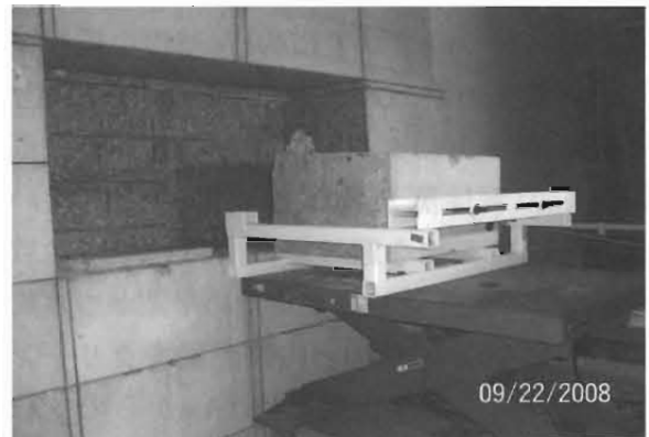
図3 切断撤去されたコンクリートブロック
